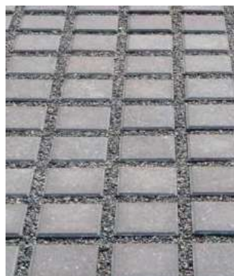
Pavés drainants avec joints granulats
