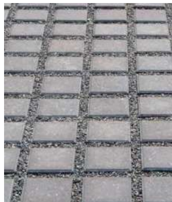
Pavés drainants avec joints granulats
