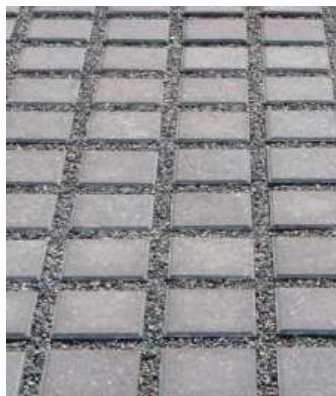
Pavés drainants avec joints granulats
