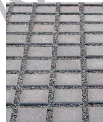
Pavés drainants avec joints granulats
